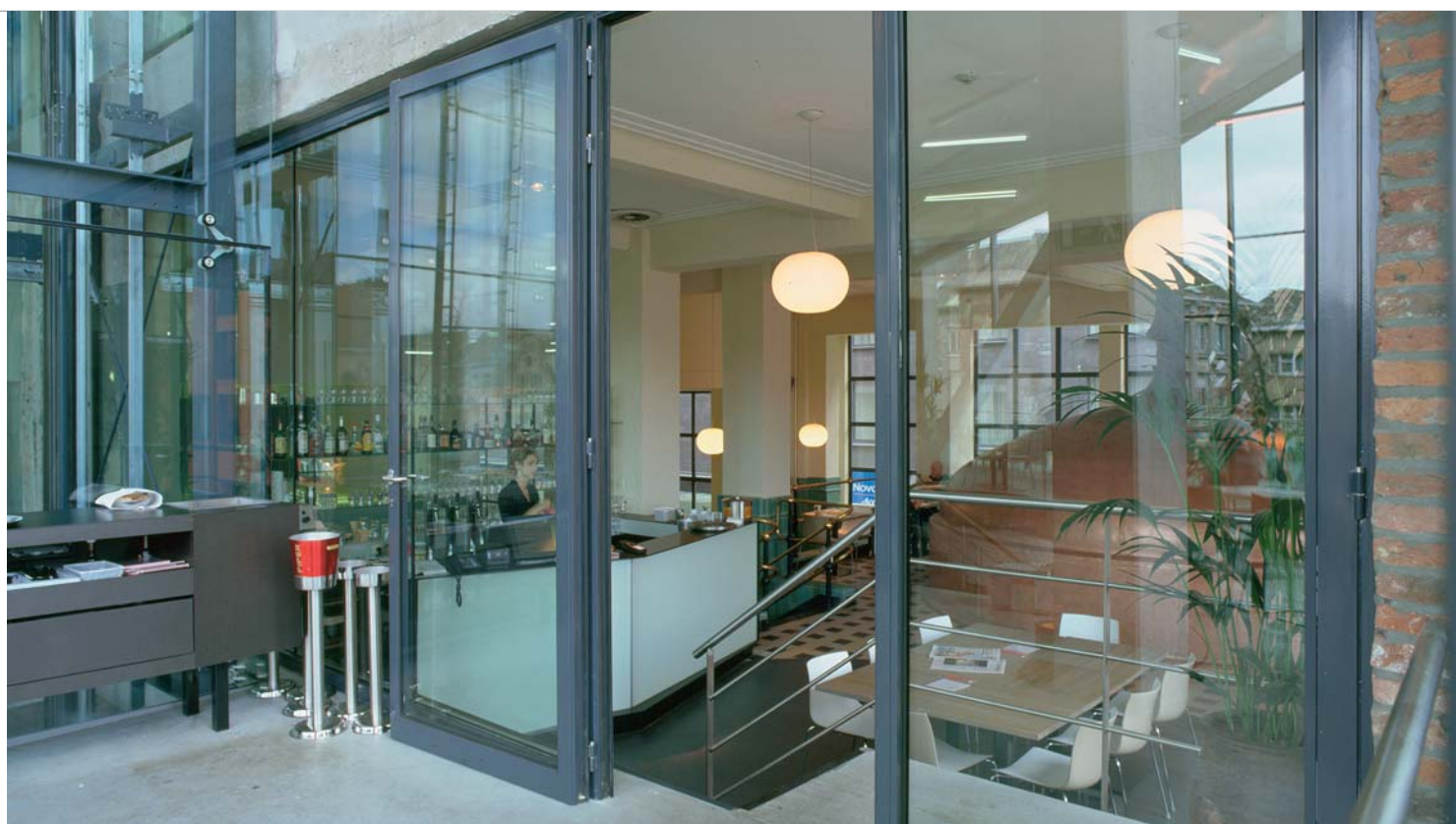
De inpandige wand is uitgevoerd met SGG Swissflam Structure 60 minuten brandwerend glas. Foto: Vetrotech Saint-Gobain
