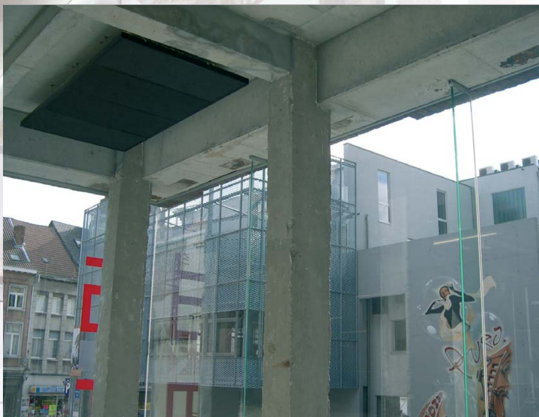
De vliesgevel met Thermobel Energy glas van AGC sluit aan op het oude betonskelet. Foto: Rik Vollebregt
