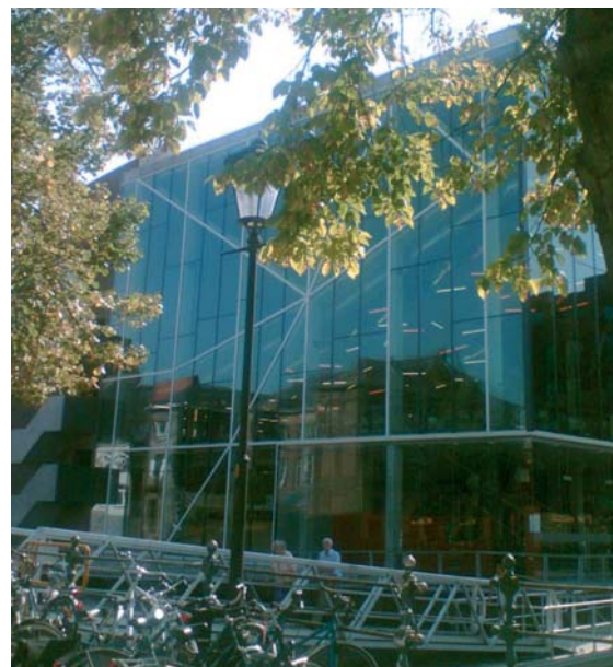
De vliesgevel is voorzien van Thermobel Energy glas van AGC. Foto: AGC
