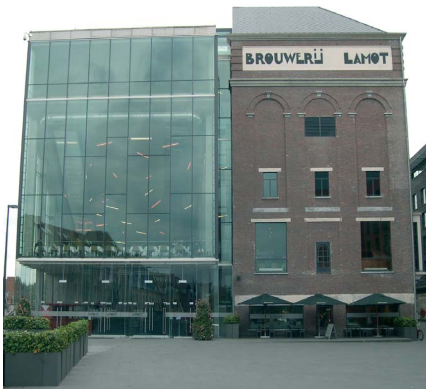
Lamot met rechts de oude brouwerij en links de nieuwe vliesgevel met Thermobel Energy glas van AGC. Foto: Rik Vollebregt
