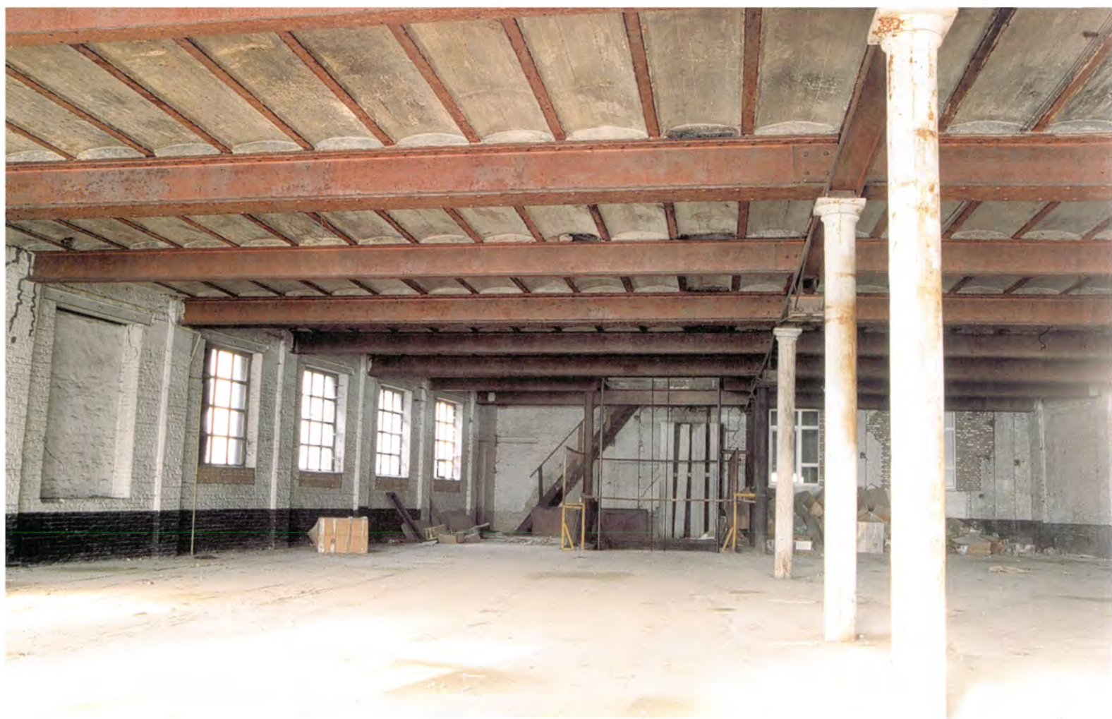
De architecten willen zoveel mogelijk industriële elementen van het pand behouden.
