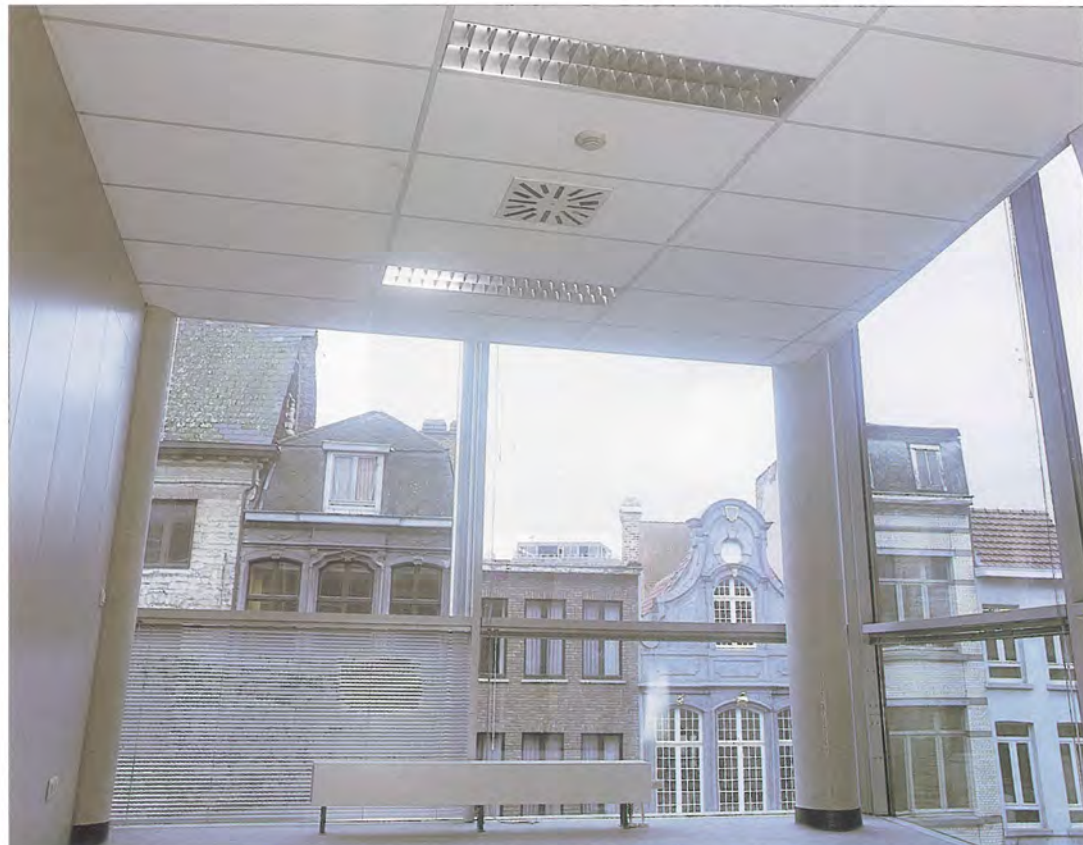
De firma Armstrong heeft in dit project het Ultima-plafondsysteem geïntegreerd (Doc. Armstrong)
