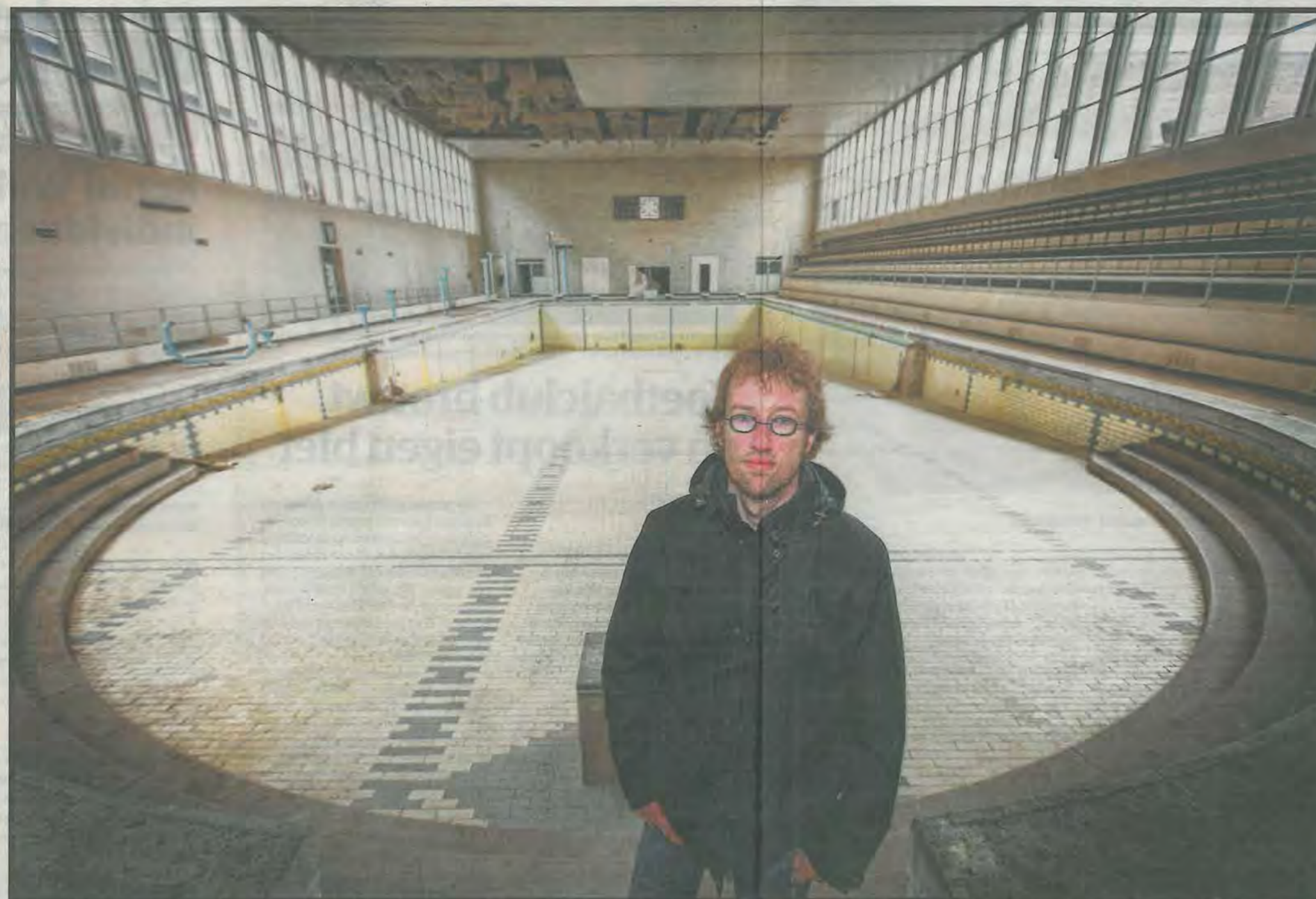
Architect Marc Debatty staat in het zwembad. Door lekken in het dak is een vochtprobleem ontstaan, en komt het plafond naar beneden. FOTO'S DIRK VERTOMMEN
