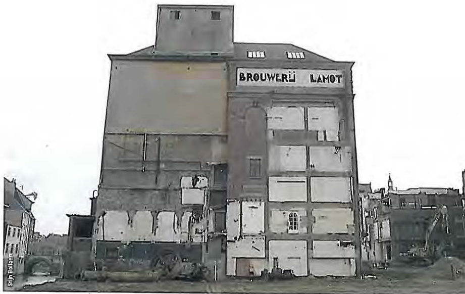
Stato dell'edificio prima dell'intervento The building before the intervention
